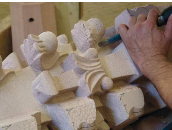
Abb. 4: Fialteil vom Bäckerlicht am Freiburger Münsterchor aus Lahrer Buntsandstein.
